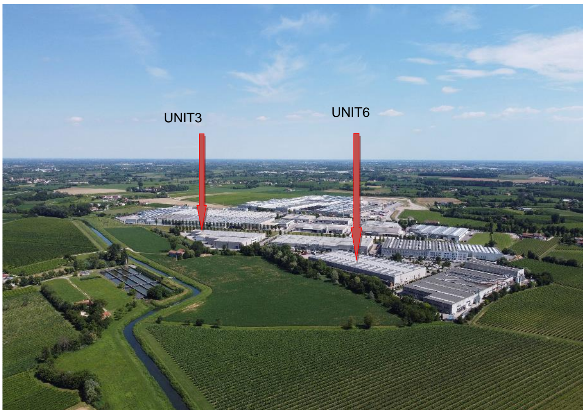
Vista aerea da est – Stato di fatto della UNIT3 e della UNIT6
